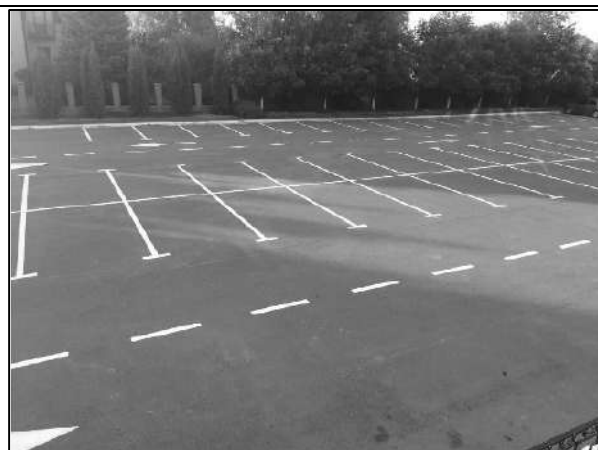
Устройство парковочных пространств
