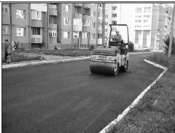
Асфальтирование дворовых проездов
