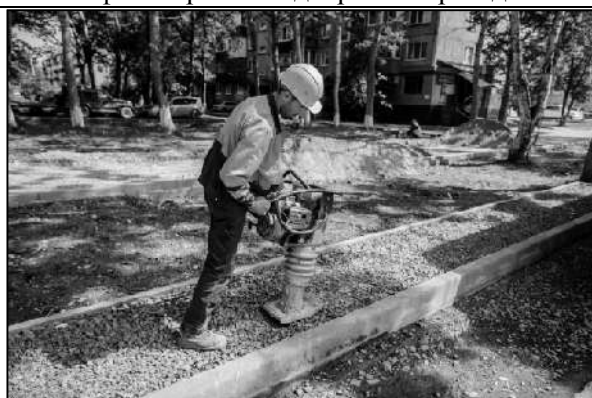
Устройство (ремонт) тротуаров
