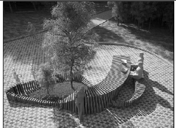
Установка малых архитектурных форм
