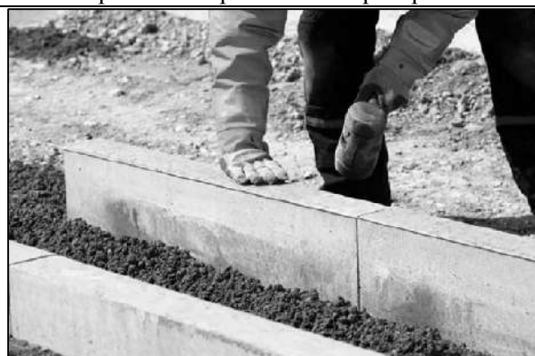
Установка или замена бордюрного камня
